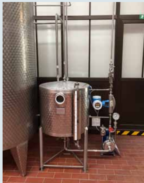
Promass F per la misura di alcol dopo la distillazione
