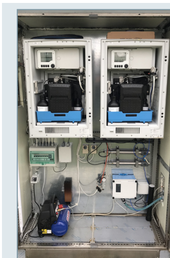
Depuratore di Pero
