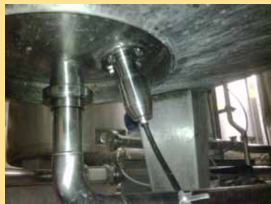
Connessione al processo base serbatoio
