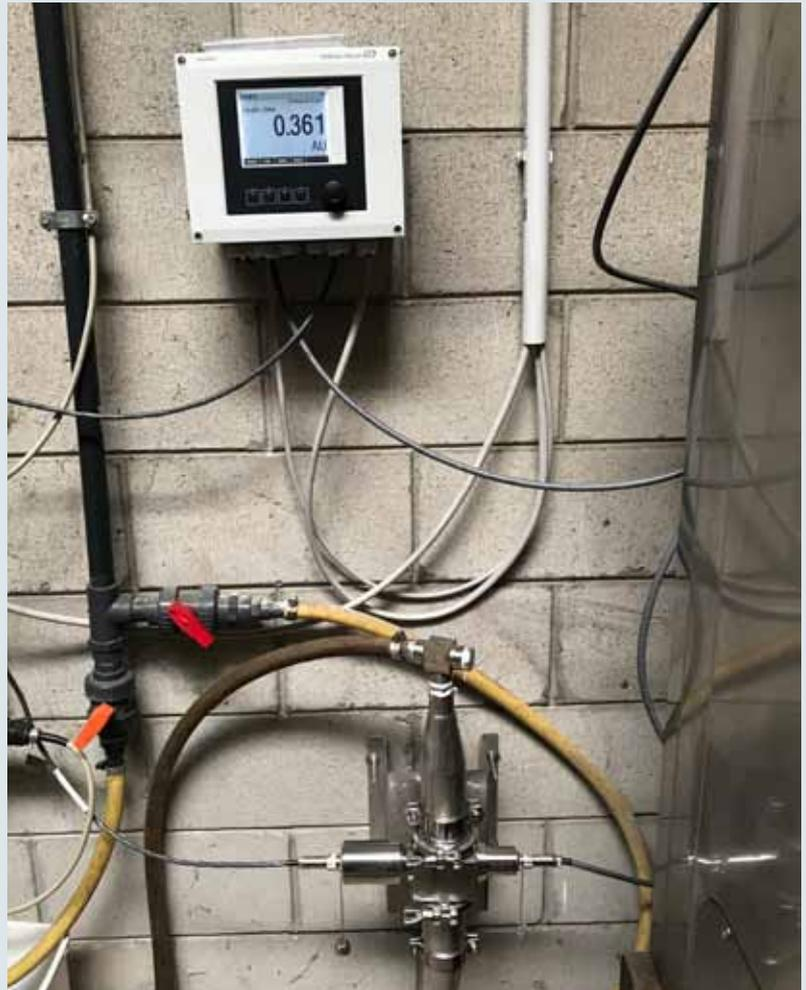
Sensore e centralina per la misura del colore CM44P+OUSAF12
